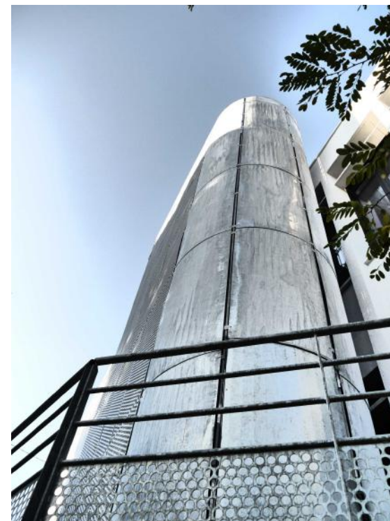
Escalier de secours de la Villa Saint-Hilaire © Florence Mialhe - coll. Villa Saint-Hilaire
